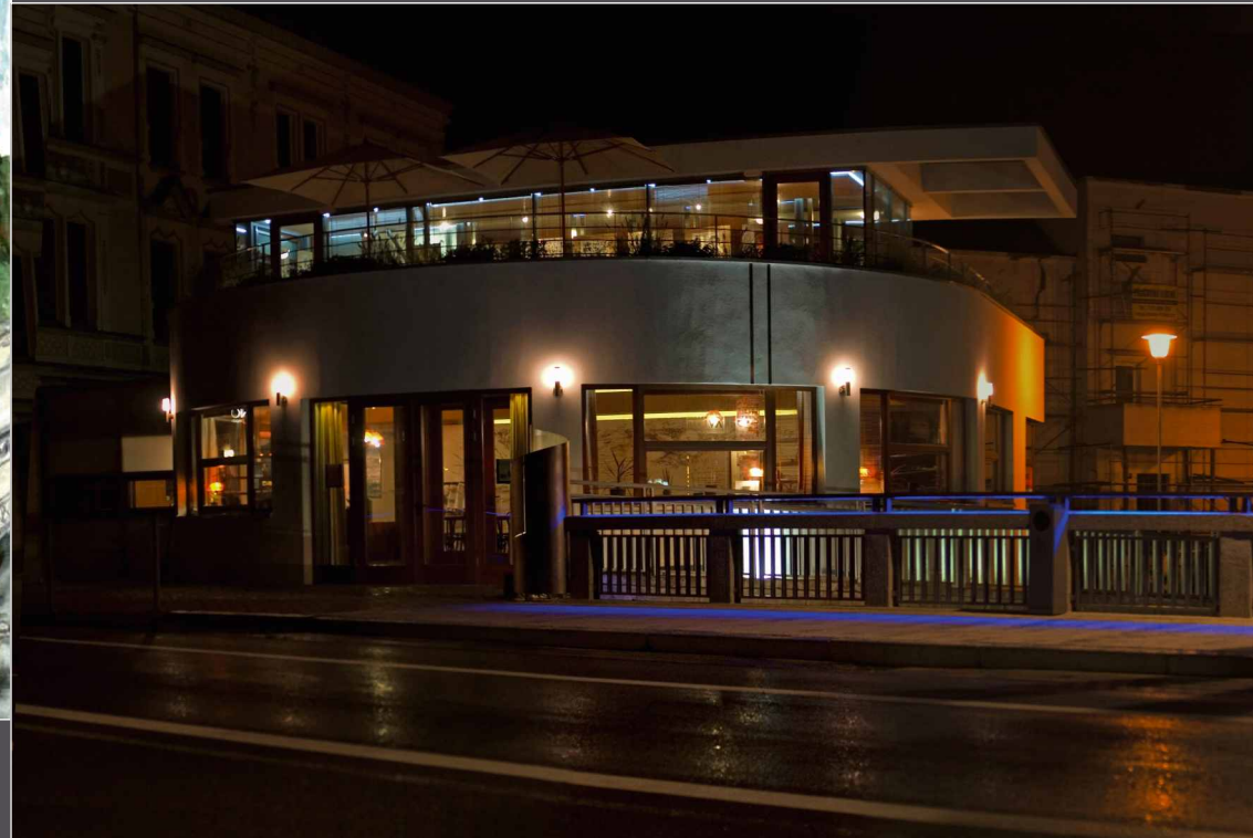
■ Pohled na zrekonstruovanou budovu Noiva při večerním osvětlení
