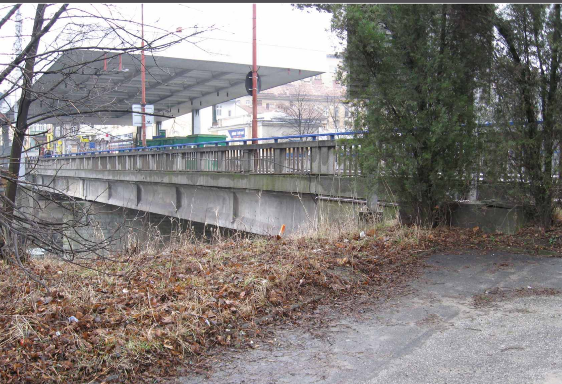
■ Pohled na původní most s celnicí
